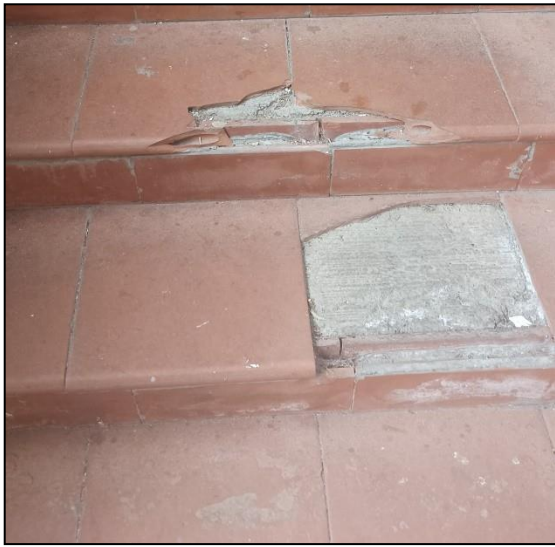
Σπασμένα πλακίδια σε εξωτερικές σκάλες
