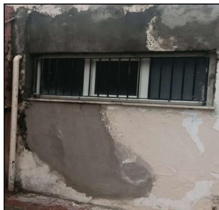
Τουαλέτες μαθητών/τριων εξωτερικά (πρόβλημα υγρασίας από παρτέρι)
