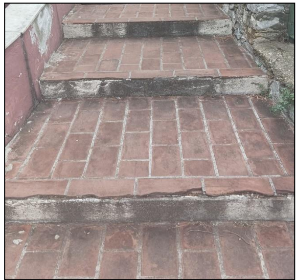
Σπασμένα πλακίδια σε εξωτερικές σκάλες
