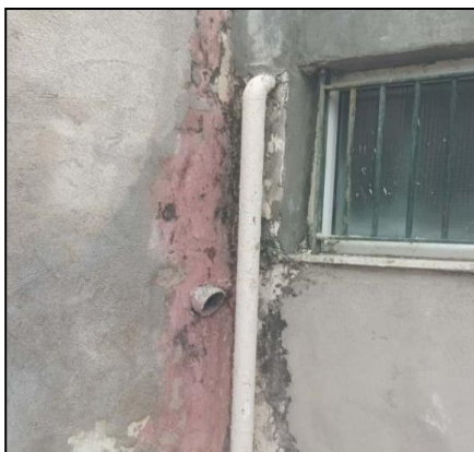
Τουαλέτες μαθητών/τριων εξωτερικά (πρόβλημα υγρασίας από παρτέρι)
